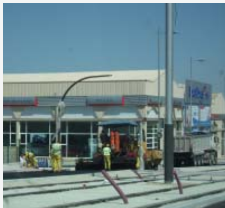
Obras del tranvía en la capital.
